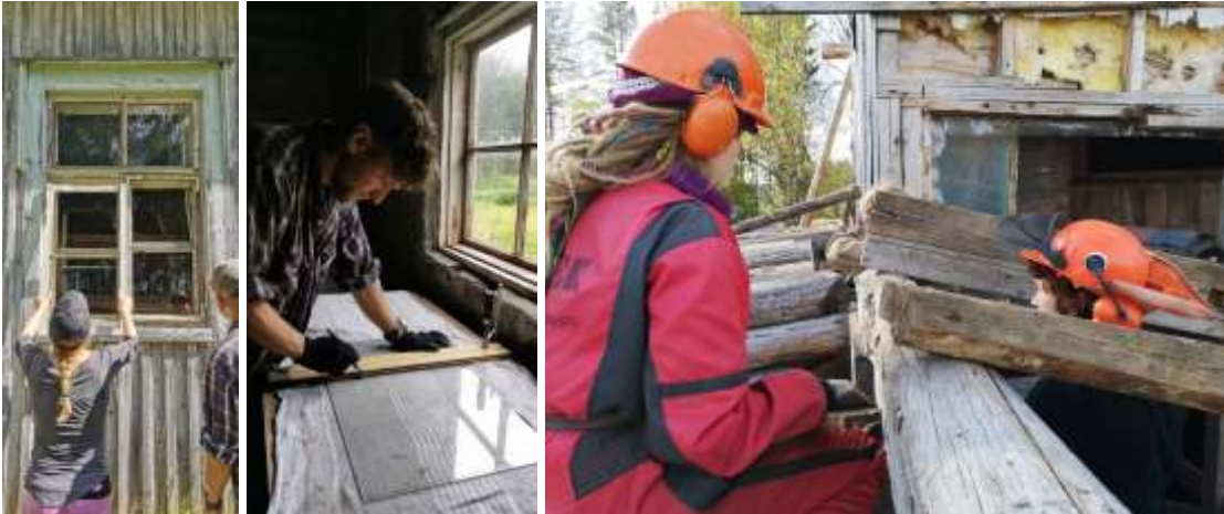
Ikkunoidenkunnostusta Repokankaalla ja Rumolan kattotyömaata
