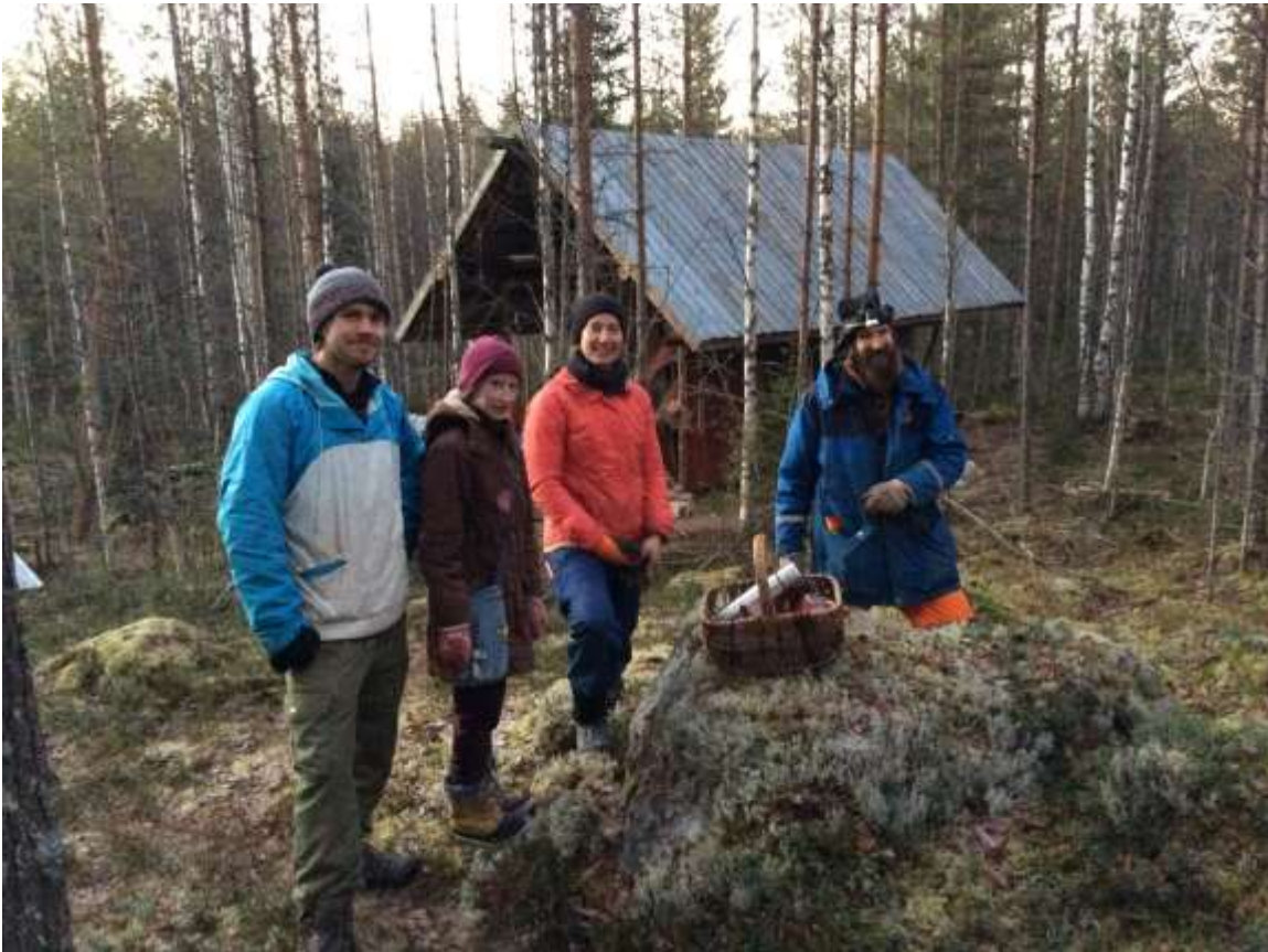
Huussi-kompostirakennuksen katto on valmistunut
