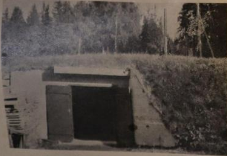
Kuva 3 Turpeilla päällystetty betonikellari.
