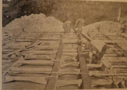
Kuva 25. Perunakellarin betonilaipion tekoa.
