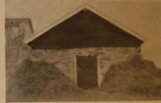
Kuva 4. Maakivistä tehty kellari; seinät peitetty osittain maatyteellä.
