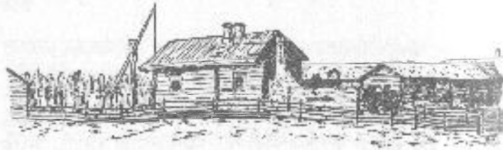
196. Pusan talo (kesken korjausta). Kirstinällä.
